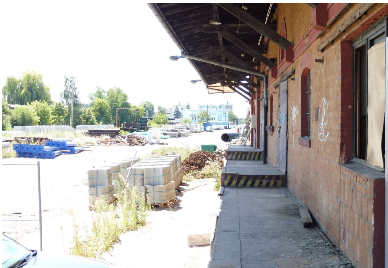
Fot. 5. Historyczny budynek hali magazynowej ekspedycji kolejowej
