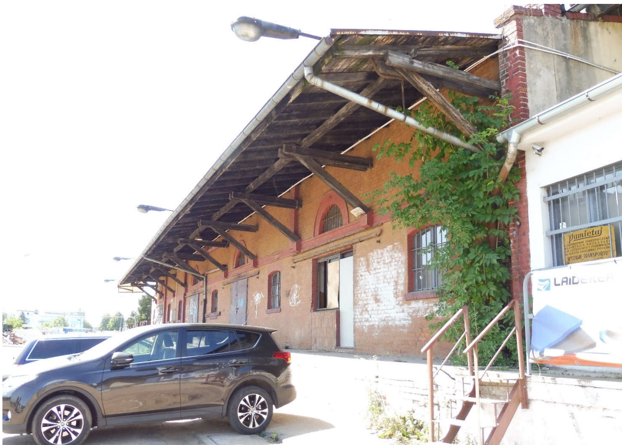
Fot. 1. i 2. Historyczny budynek hali magazynowej ekspedycji kolejowej
